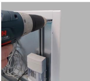
2. Просверлите отверстие во внутренней части шкафа с помощью электродрели.
